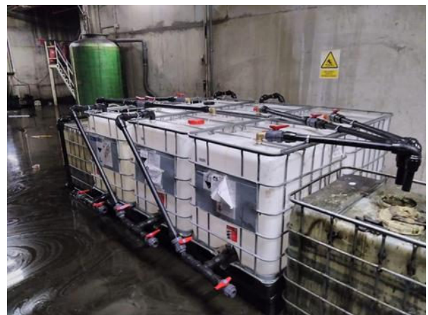
Extracción de emergencia de aceites, automoción (intervención de urgencia).
